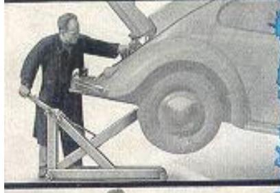
2 Motor Aus- u. Einbau durch 1 Mann
